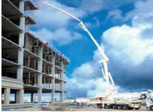
Resim 1.11: Pompayla beton dökülmesi
