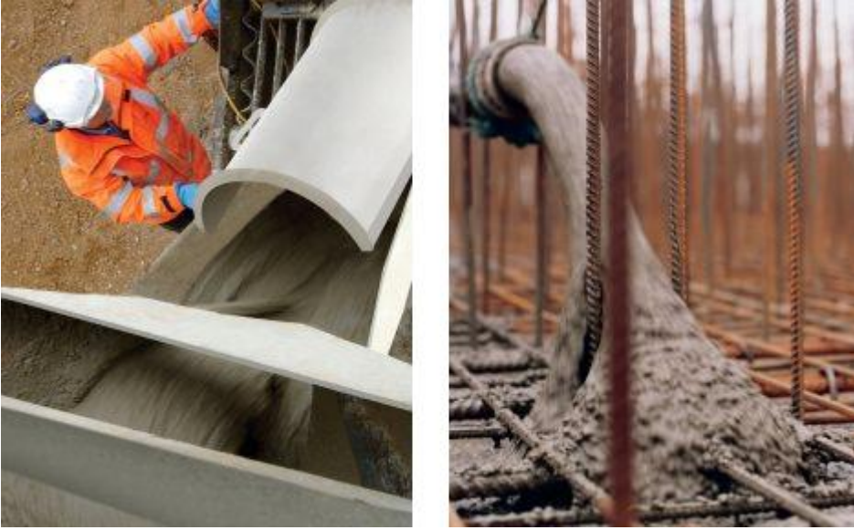
Resim 6.4: Kendiliğinden yerleşen beton uygulamaları
