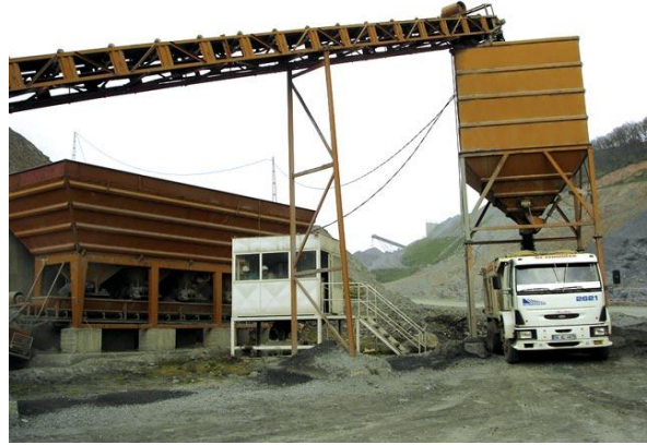
Resim 1.16: Transmiksera beton dolumu
