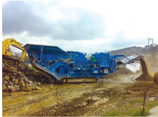
Resim 1.3: Malzeme ocağında hareketli kırma taş makinesi
