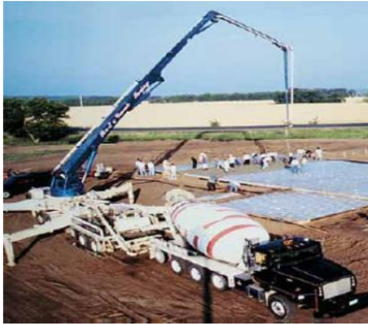
Resim 1.10: Pompayla beton dökülmesi
