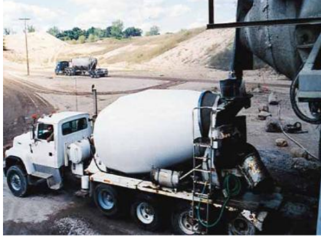
Resim 2.1: Transmikserle beton doldurulması
